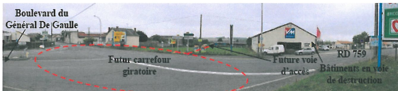
SITE DE LA CROIX THIBAUT Photo n° 2 du 20/09/2011
