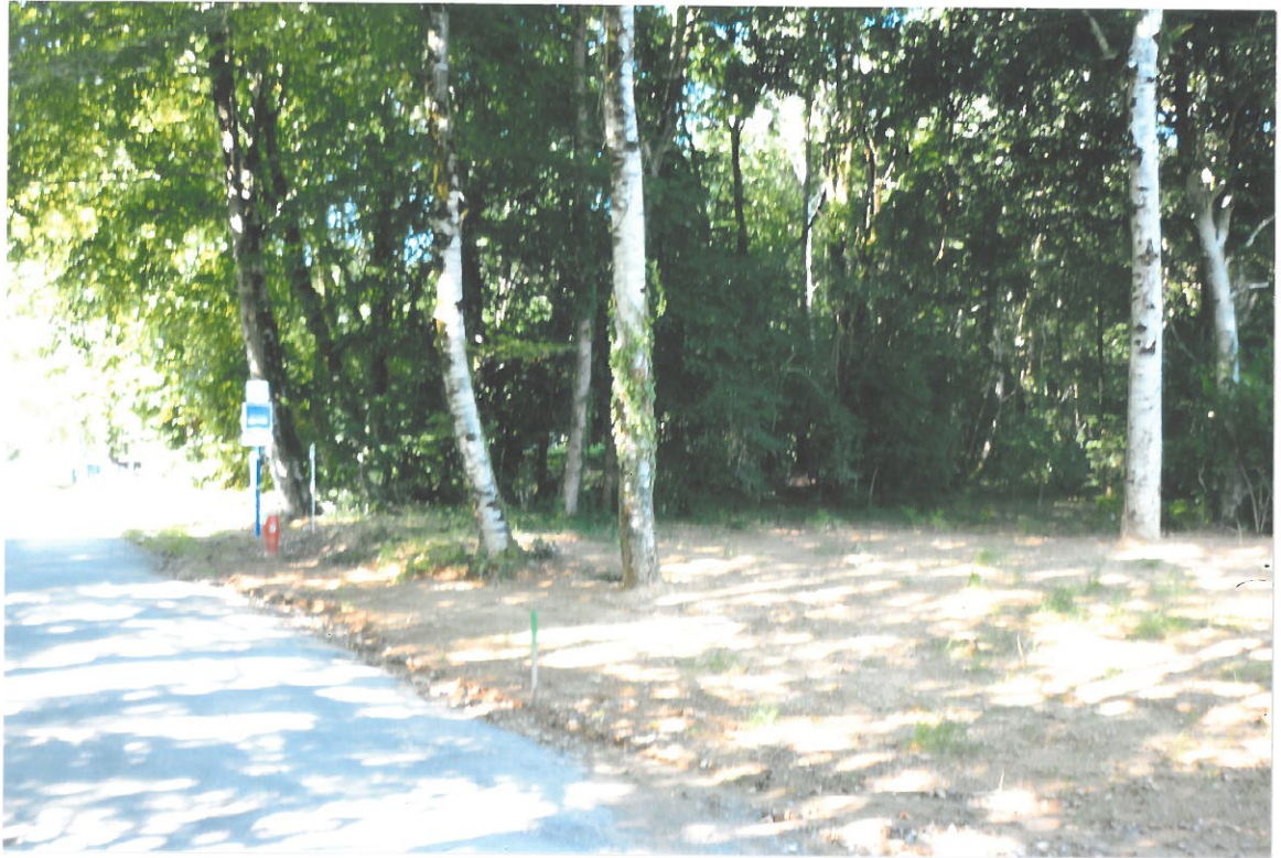
ROUTE DU GRAND COLONBIER (SENS SUD-NORD) AVEC ARBRES DU BORD DE ROUTE A ABATTRE
