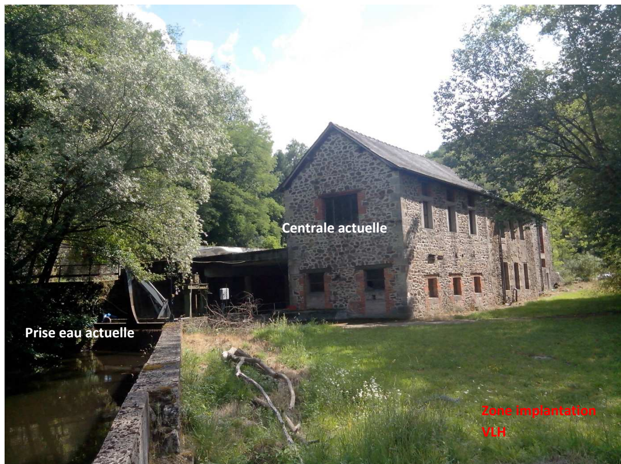
Photographie 4 - Bâtiment centrale actuelle vue de l'aval (prise le 2 juillet 2014)
