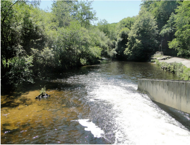
La Vienne à l'aval du seuil existant
