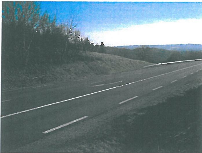
Photo 1 : vue depuis le secteur Est sur la partie Sud du fuseau de la RD 1089 susceptible d'accueillir le rond point
