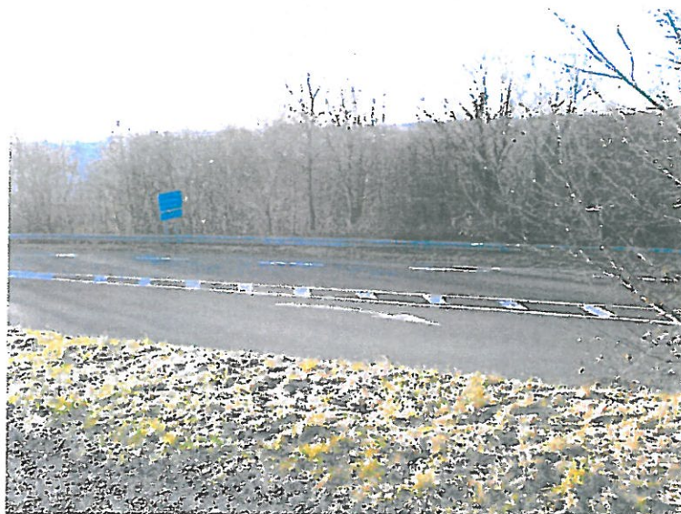
Photo 3 : Vue depuis le secteur ouest du secteur Sud de la RD 1089
