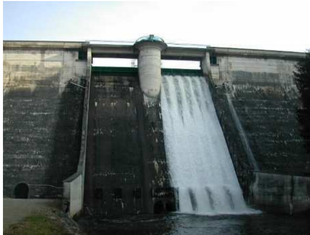
Vue aval de l'évacuateur de crues
