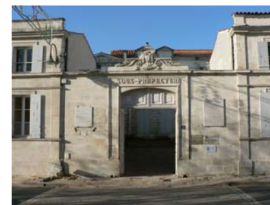
ancienne Sous Préfecture - rue François Fresneau
