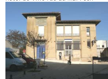
La Poste - place de verdun
