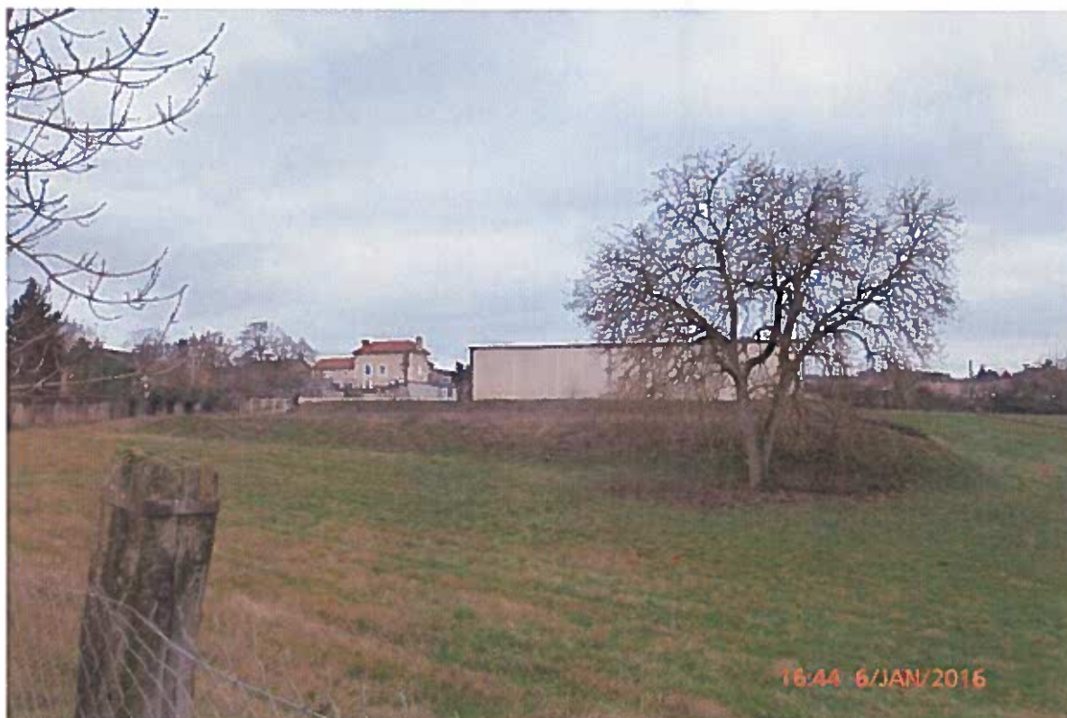
Vue sur un bâtiment qui n'embellit pas la vallée
