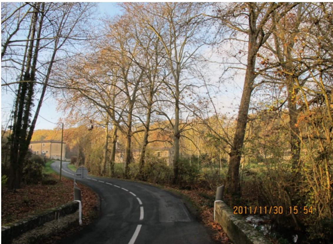
Photo 15 Pont sur la Menuse à Mezeaux, traversée par la RD 87 ; la chapelle se trouve à la sortie de l'alignement de platanes.
