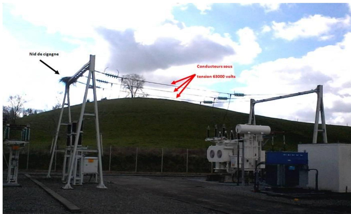
Les nids, constitués de branches d'arbre et posés sur notre support, entrent en contact avec les conducteurs sous tension 63000 Volts et créent des courts-circuits suivis de multiples coupures de courant sur le territoire impactant 30000 clients.
