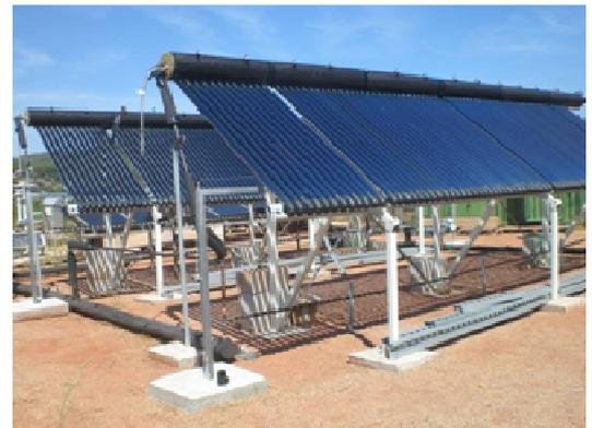
Ce « champ solaire » de 800 m<sup>2</sup> pour une puissance de 350 KW sera implanté dans l'enceinte technique du quartier regroupant la production solaire, la chaufferie mixte Biomasse - Gaz.
