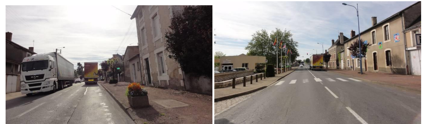
Traversée du centre-bourg de Lussac, PR 19 (à gauche) et 20 (à droite) (Sens Poitiers -> Limoges)
