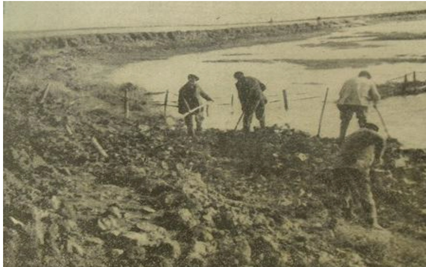
Illustration 6 : Colmatage de brèches à Sainte-Radegonde-des-Noyers [source : AD de la Vendée]
