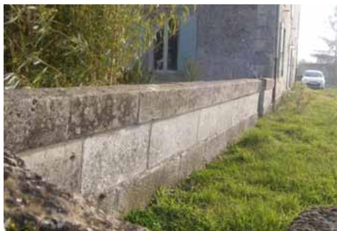
Couvrement et muret en pierre de taille avec un soubassement saillant
