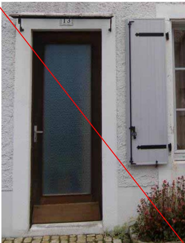
**Menuiseries standard, inadaptées : porte vitrée sur toute la hauteur, vitrage translucide, volets en PVC, quincailleries foncées sur volets de teinte claire**
