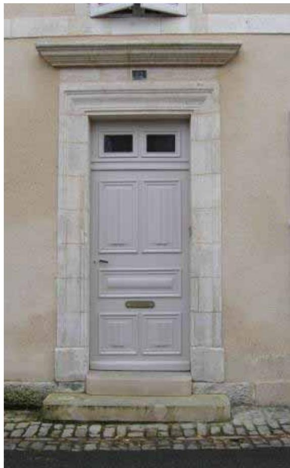
L'enduit traditionnel à la chaux sur les parties maçonnées en moellons met en valeur les encadrements de baies et les décors en pierre de taille
