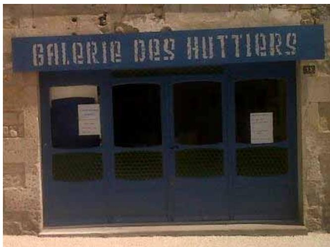
**Devanture « en feuillure » : elle est placée dans l'épaisseur du mur de façade ; (L'enseigne par contre est ici en applique, en avant dur mur).**
