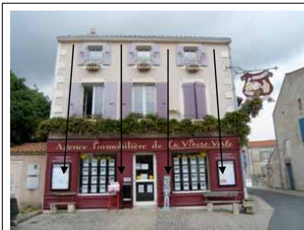
Respect de la composition de la façade au niveau de la devanture commerciale : les trumeaux maçonnés et les baies se superposent verticalement. La descente des charges reste lisible.
