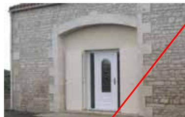
**Bouchement de baie et mise en place d'une menuiserie standard**
