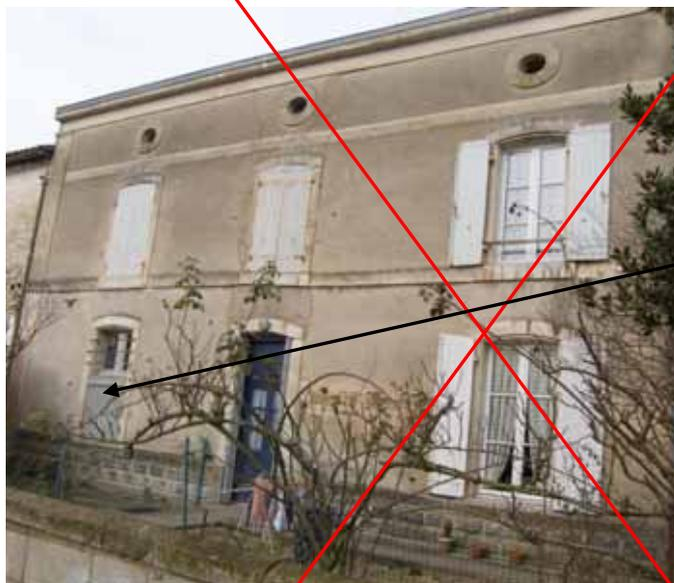
**Cette façade bénéficie d'une belle composition symétrique avec des linteaux de baie courbes et des petites baies d'attique ovale. Malheureusement une baie a été bouchée partiellement et une nouvelle menuiserie aux profils épais a été mise en place. Des barreaudages ont été rajoutés. Les volets ont été supprimés : ces transformations griment la façade et concourt à la perte de son identité architecturale**
