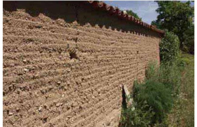
**Murs de clôture en terre, le mur peut également être enduit (enduit à la chaux).**
