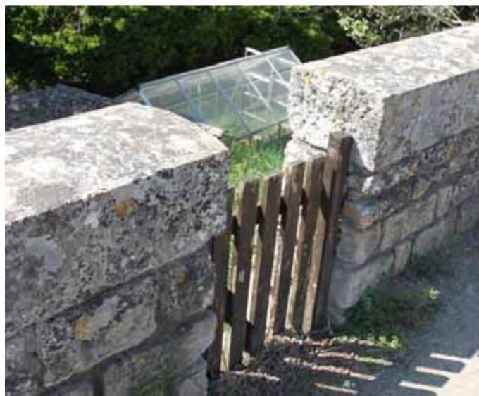
Couvrement en pierre de taille (à 2 pentes ou bombé, d'épaisseur variable supérieure à 15cm) et muret en moellons rejointoyés
