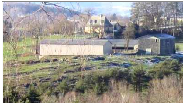
Figure 9 : A Reygades la ferme est construite sur l'affleurement rocheux. Les plus anciens bâtiments sont faits de blocs de serpentines
