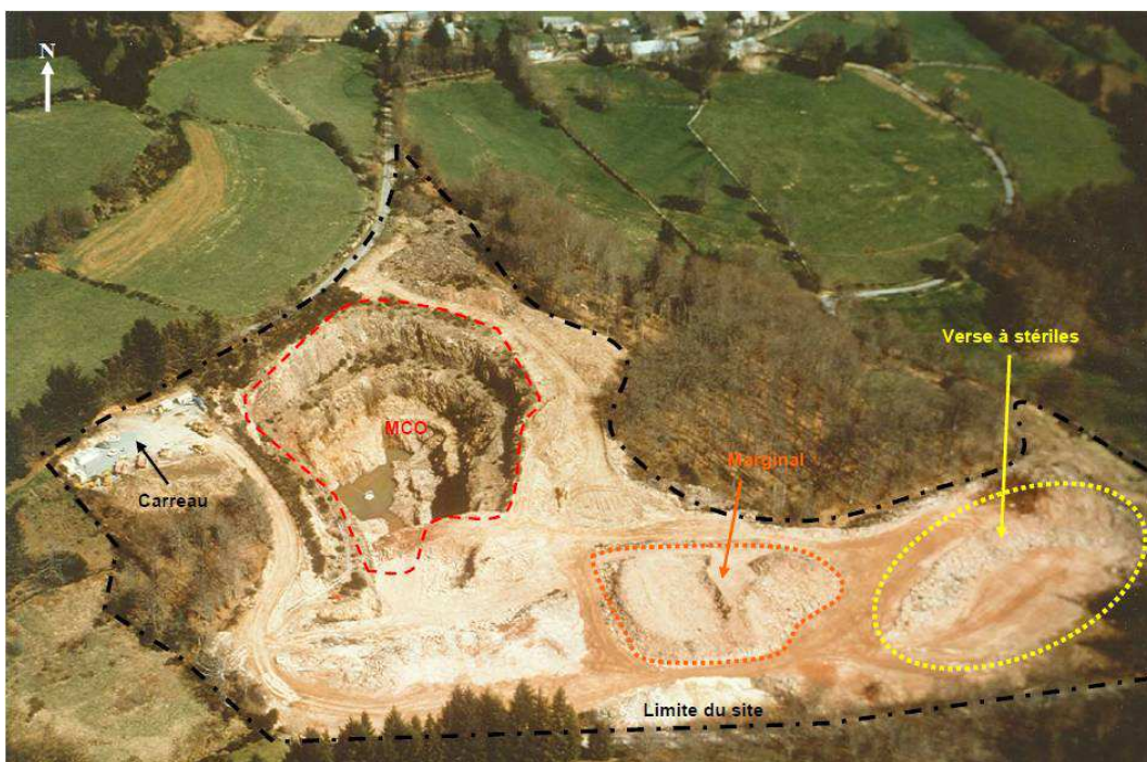
Figure 6 : Vue aérienne du site en avril 1993
