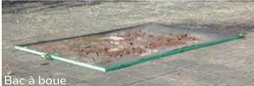
Figure 19. Photographie d'un bac à boue.
