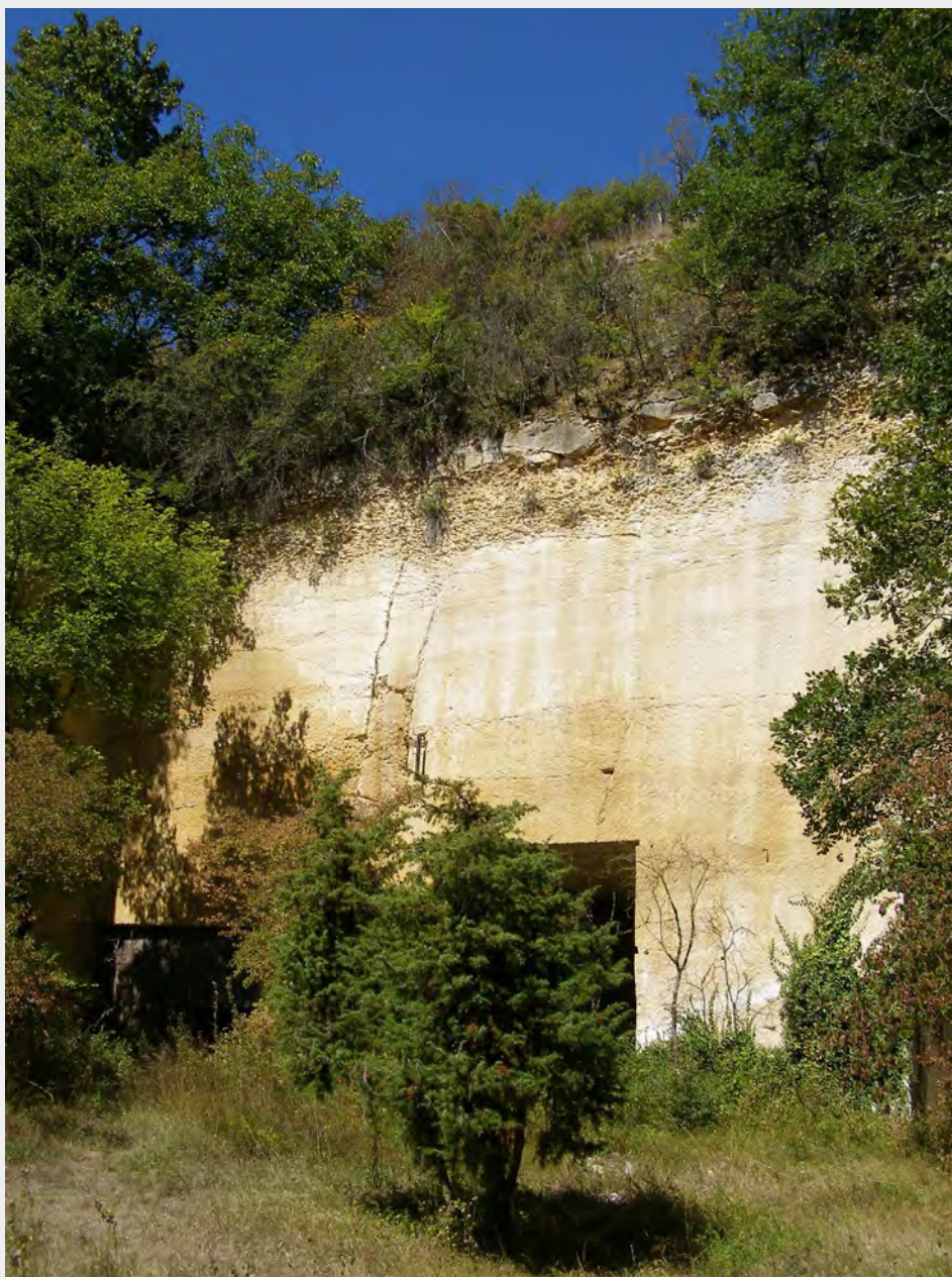
Vue partielle de la carrière de la Frémigère. Noter, à la base du front de taille, la présence de deux chambres d'exploitation souterraine et, à son sommet, la gélifraction des niveaux proches de la surface.
