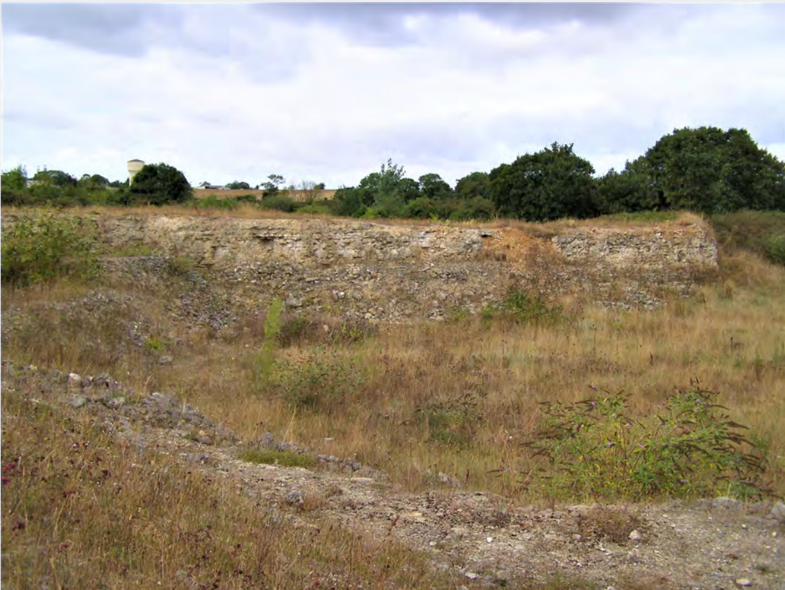
Vue générale de la carrière de Buffevent en juin 2002 [en haut] et vue partielle en septembre 2020 [en bas]. Le château d'eau en arrière plan constitue un point de repère. (photos : Didier Poncet)
