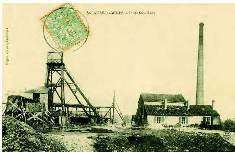
Figure 5 – Chevalement du puits Sainte-Claire (Saint-Laurs). Ouvert en 1861 et utilisé jusqu'en 1903, ce puits exploitait des veines de charbon du bassin houiller de Vouvant. (collection particulière)
