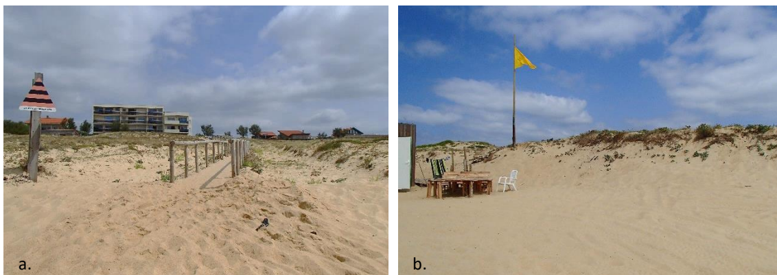
Figure 9 : Sites dépourvus de clôtures, a. débouché d'un accès sur la plage Sud, b. dune en arrière du poste de la Gravière (CASAGEC, 2021).
