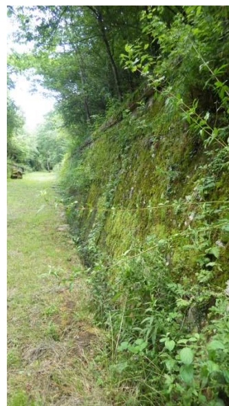
Murs aux entrées du tunnel Source : Anne Pléney
