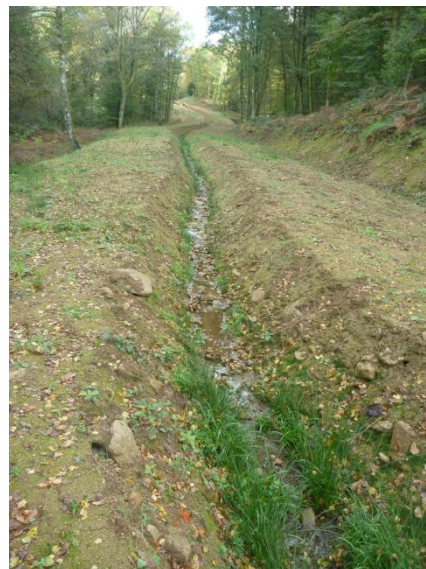
Fig. 12 : Fossé de dérivation construit en parallèle du ruisseau.
