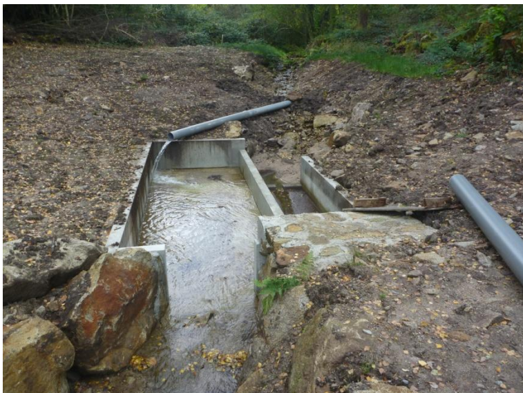
Fig. 11 : Aménagement du lit destiné à détourner l'eau vers le fossé de dérivation.
