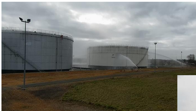
Feu de cuvette du réservoir n°7
