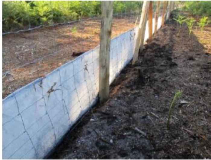
Exemples de dispositifs anti-intrusion
