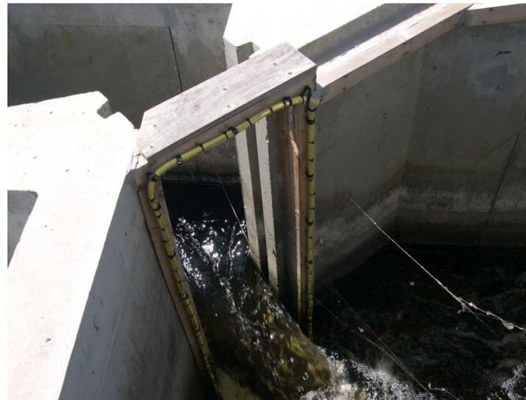
Figure 29 : Dispositif de comptage sur la passe-à-poissons, Bonneuil-Matours
