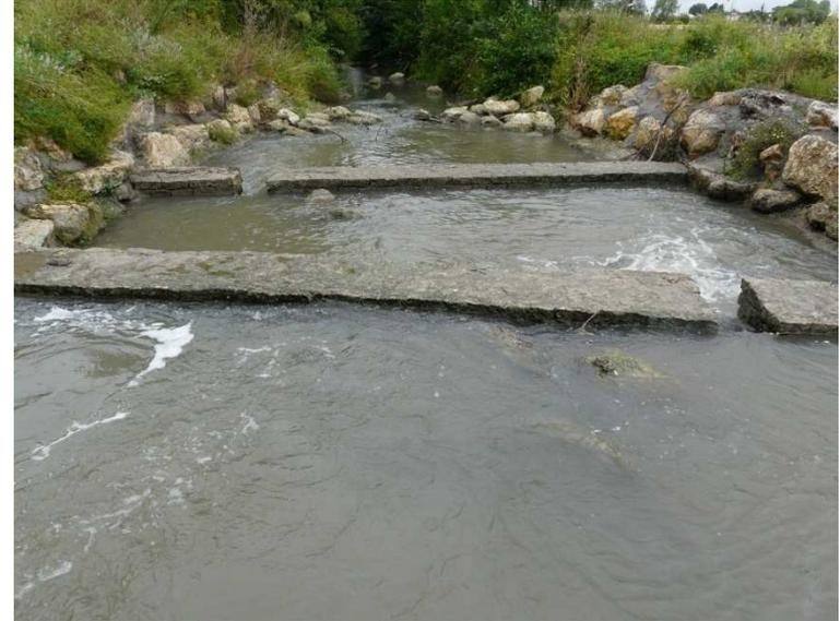
Figure 36 : Vue amont des seuils à échancrures et enrochements de berge, sur l'Ozon
