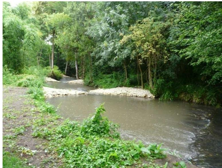
Figure 46 : Banquettes créées à l'aval du seuil pour resserrer la section d'écoulement, sur l'Ozon
