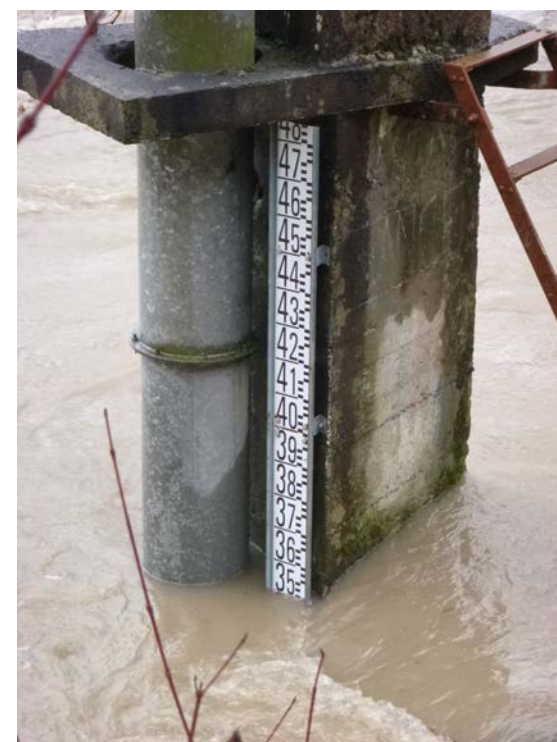
Station d'Escos et zoom sur l'échelle limnimétrique (Janvier 2018)
