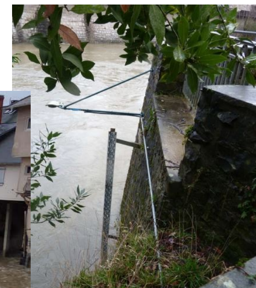
Echelle limnimétrique de Mauléon-Licharre
