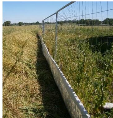
*Filet de protection temporaire implanté sur piquets (à gauche) ou sur la clôture de chantier (à droite)*
