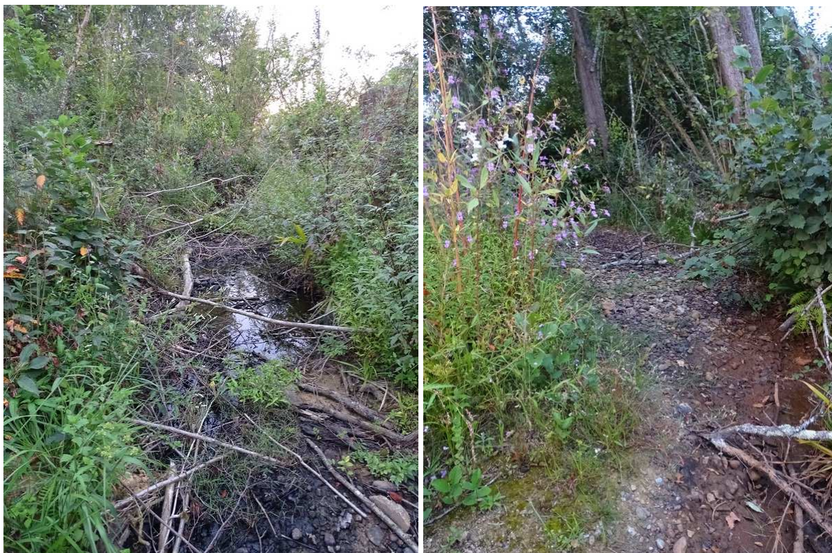
Planche photos 3. Zone avec poche d'eau et zone asséchée au droit de l'emprise du barrage
