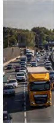
Les quatre entrées de l'échangeur n°26 sont saturées chaque jour aux heures de pointe.
