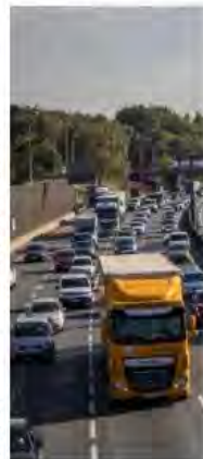
Les quatre entrées de l'échangeur n° 26 sont saturées chaque jour.
