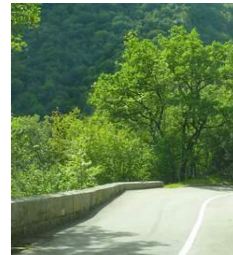
Vallée de la Loue : parapets en béton.
