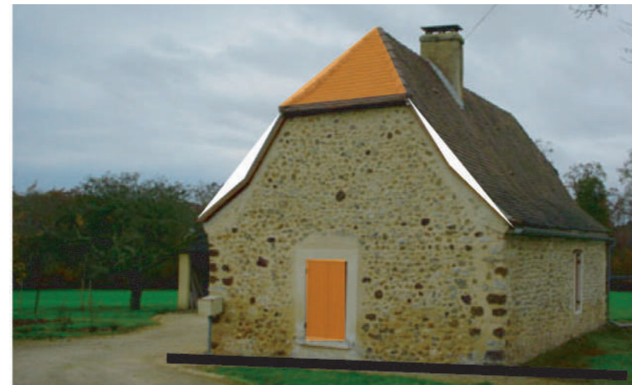
Quelques détails créent la façade sur cette architecture traditionnelle.
