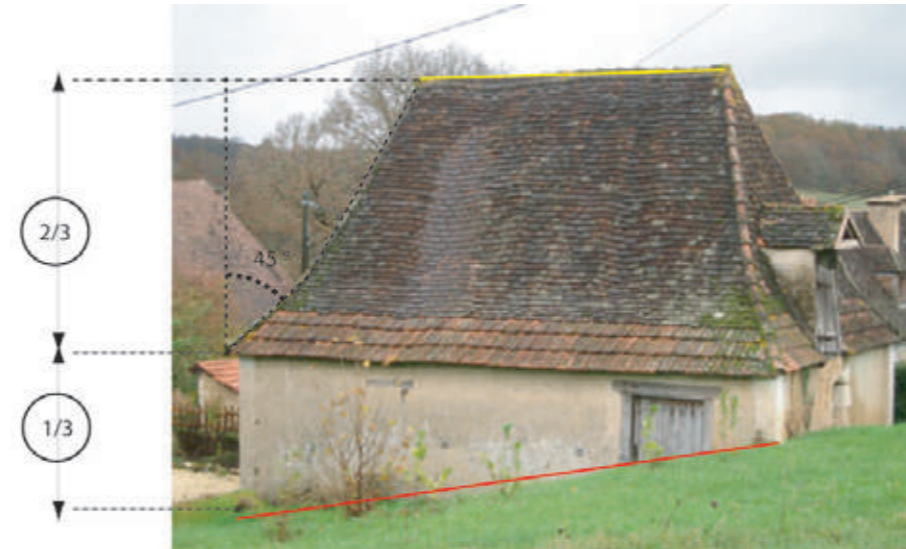
Rapports de proportion mur 1/3, toiture 2/3, et implantation dans la pente
