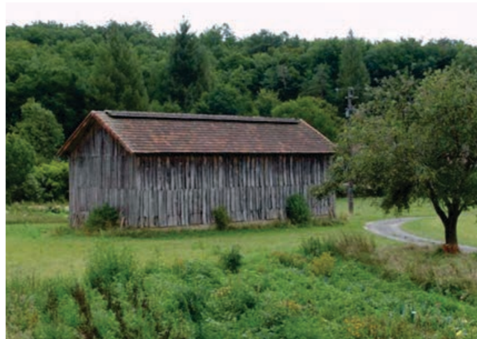
Un exemple de bâtiment « traditionnel » emblématique : le séchoir à tabac type « cathédrale » bardé en bois et recouvert de tuiles.
