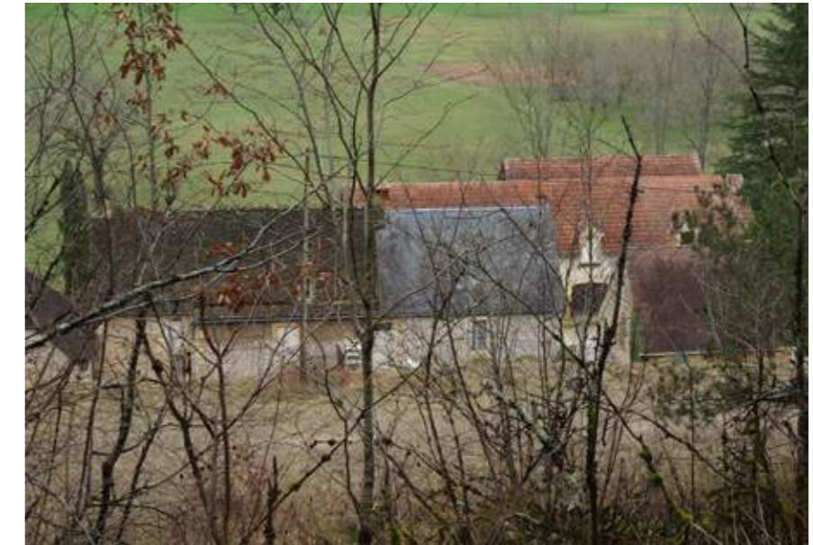
Les lignes de faîtage sont parallèles entre elles et aux courbes de niveau
