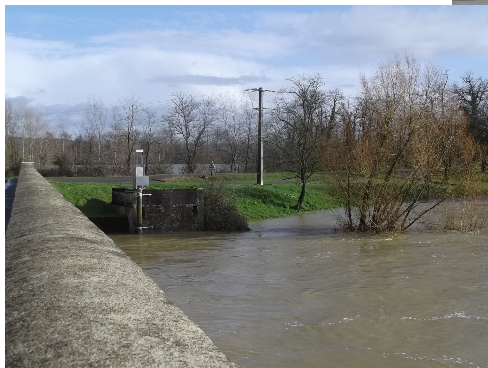
Station de Cahuzac-sur-l'Adour
