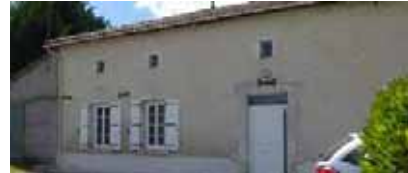
Enduits à fleur de moellon (bâti rural)
