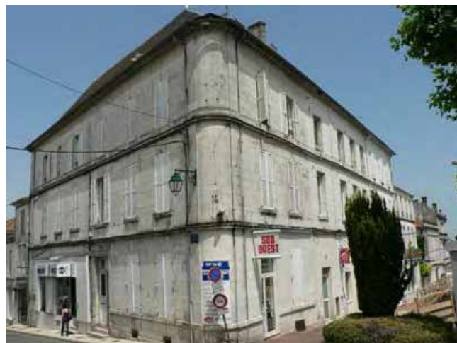
Maison d'angle au 1, rue Marcel Jambon
