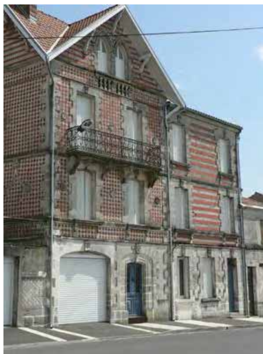
Maison de faubourg du 41, rue de la République
