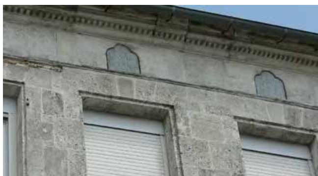
Proportion des baies et des petits carreaux (7 rue des Pilards)
