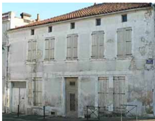
Rue Trarieux, bâti dégradé
