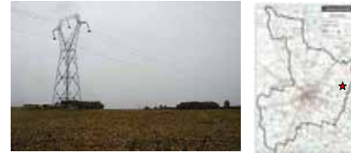
Ligne au lieu-dit « L'Abeille », Cliché Eau-Méga
