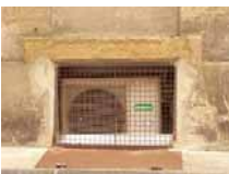
Bonne intégration dans une baie, accompagnée d'une ferronnerie...
