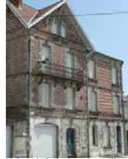
Maison de faubourg - appareillage pierre et briques
