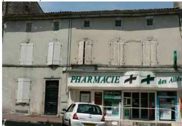
Façade d'une maison à cinq travées 30, 32, boulevard Gambetta
