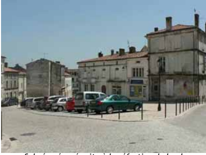
Sol réaménagé suite à la réfection de la place
