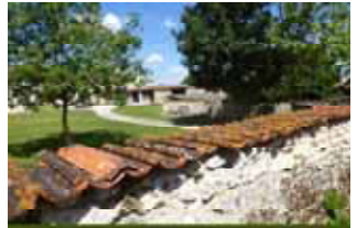
Les murs de clôture traditionnels ne sont pas enduits.
