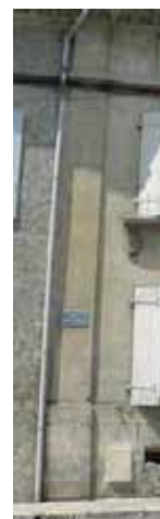
Exemple de pilastre au 1, rue Marcel Jambon
