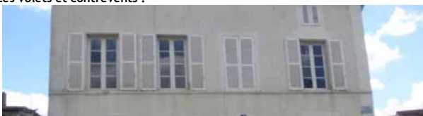
Exemple de volets adaptés au bâti
