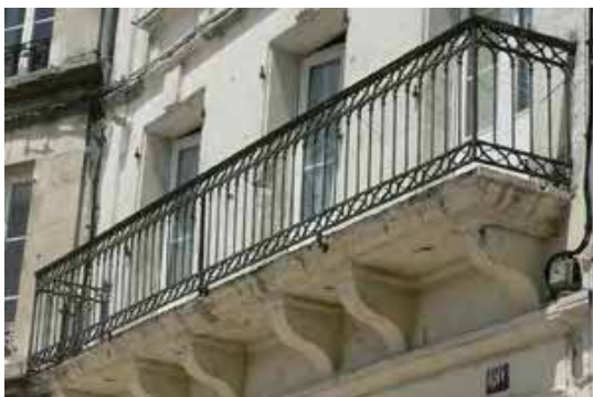
Balcon de premier étage au 60, rue Sadi Carnot
