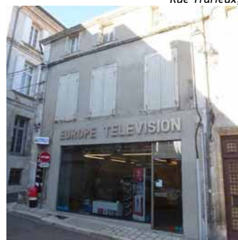
Exemple de logement condamné par la suppression d'un accès direct vers l'extérieur.
