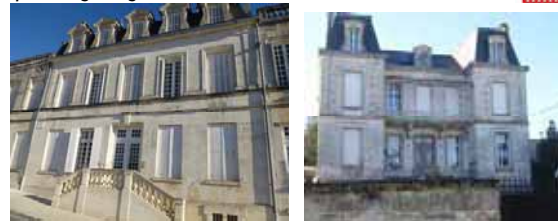
Immeubles en pierre de taille - façades travaillées (ordonnancement des baies...)
