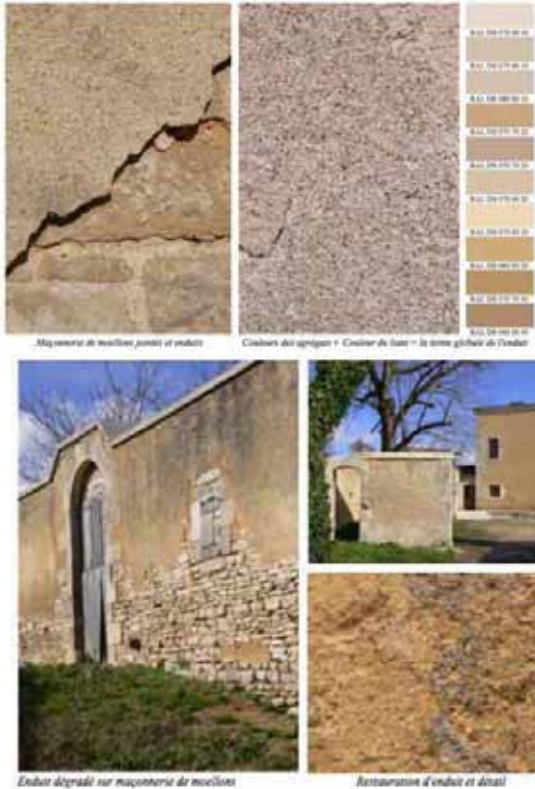
Enduit dégradé sur maçonnerie de moellons
