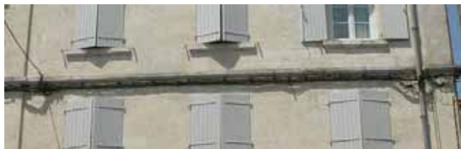
Cordons de séparation des niveaux au 23, rue Marcel Jambon
