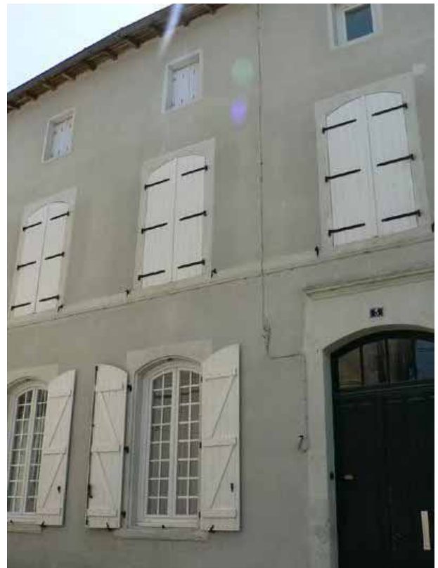
Maison à trois travées de fenêtres 3, rue de la Motte
