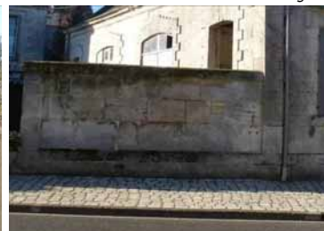
Mur plein et mur bahut, rue Victor Hugo
