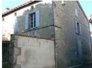
Maison de ville - moellon partiellement enduit du pignon.
