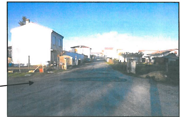
PHOTO 3 Chemin existant menant à l'Avenue de la République
