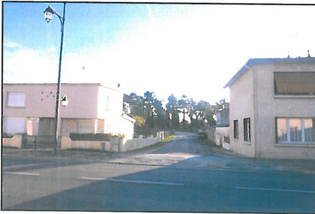
PHOTO 12 : Vue depuis l'Avenue de la République
