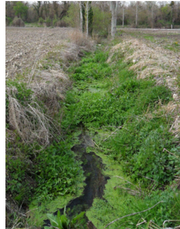
Photo 7 : Fossé en aval de la buse
