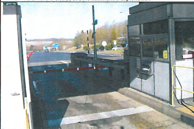
7. Vue d'une voie de péage
