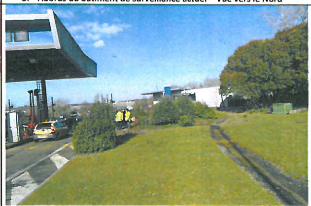
6. Abords de la zone de la barrière de péage
