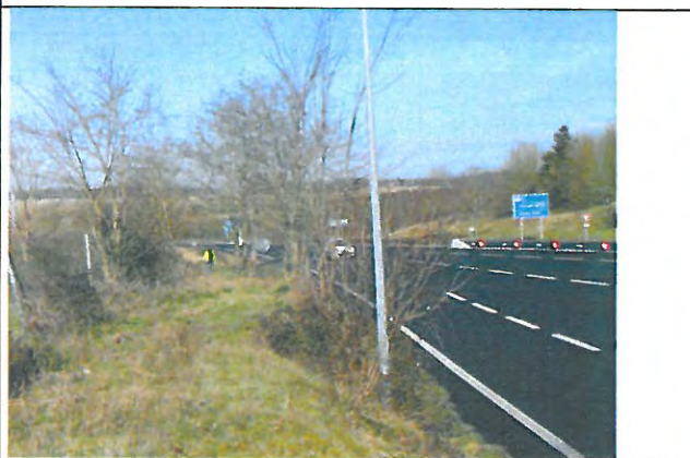
16. Fin d'entonnement vers A10 – zone de talus
