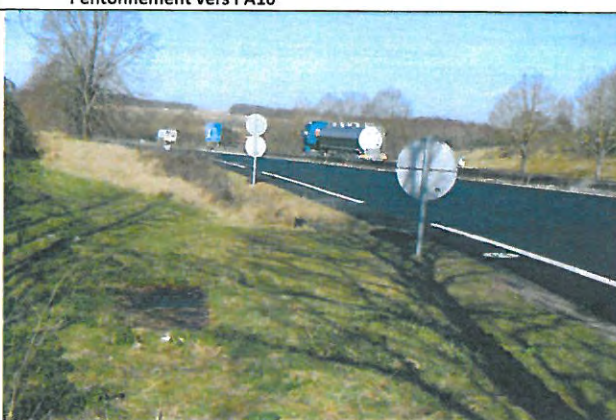
17. Fin d'entonnement vers A10 – zone de talus – limite Sud
