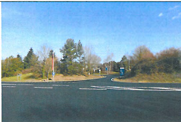
20. Vue de la voie de service, accès depuis Saintes
