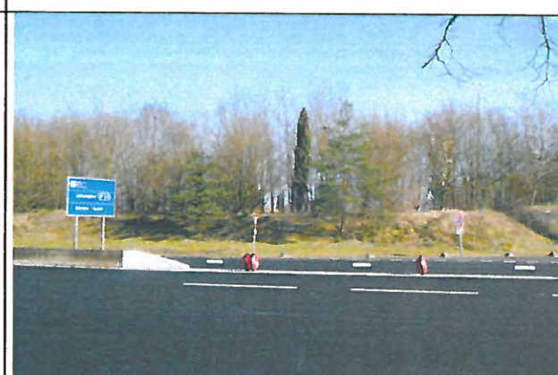
18. Fin de zone de péage, côté A10 – Vue vers le Nord
