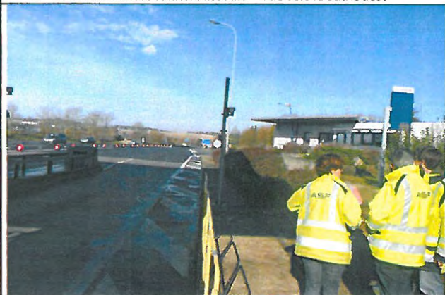
4. Voie Nord d'entrée avec le bâtiment d'exploitation
