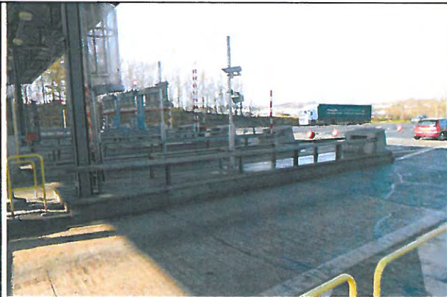
1. Voie d'entrée sur l'Autoroute A10 – Vue vers le Sud-Ouest
