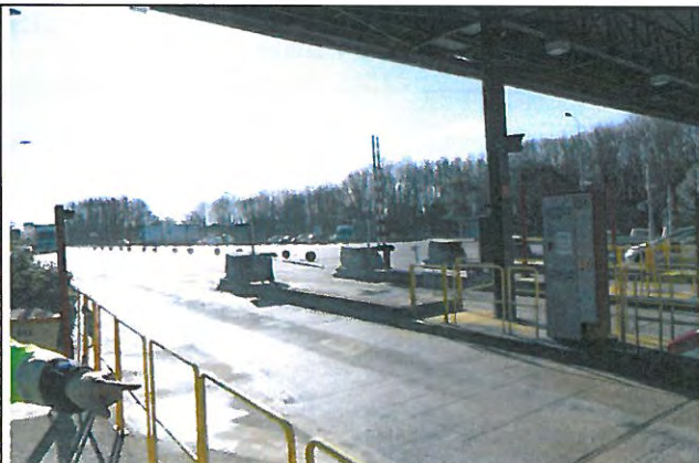
2. Voie d'entrée sur l'Autoroute A10 – Vue vers le Sud-Est
