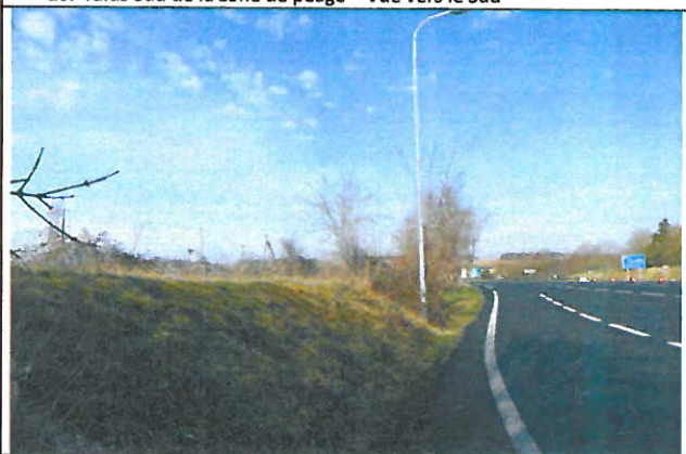
13. Limite Sud de voirie dans l'entonnement vers l'A10 – Côté Sud
