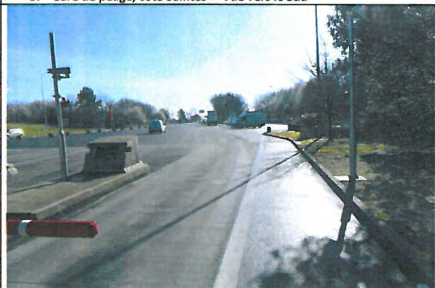
8. Voie de sortie Sud du péage
