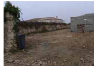
Mur "à préserver impérativement" démoli pour permettre une nouvelle construction
