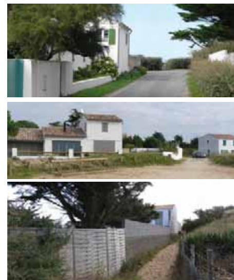
Des maisons visibles depuis le rivage et des clôtures à gérer
