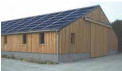
Image 1 : implantation de capteurs sur 100% de la couverture
