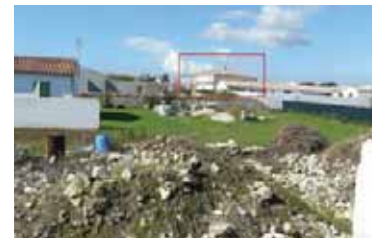
La grange de l'Abbaye aujourd'hui noyée au milieu de constructions neuves
