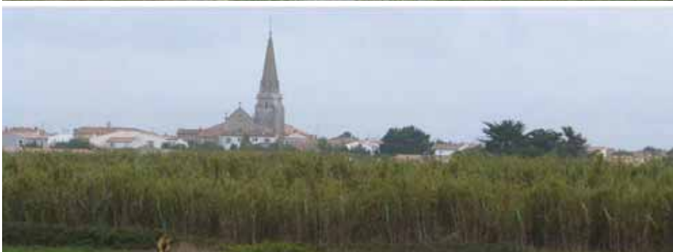
Depuis le site classé au sud
