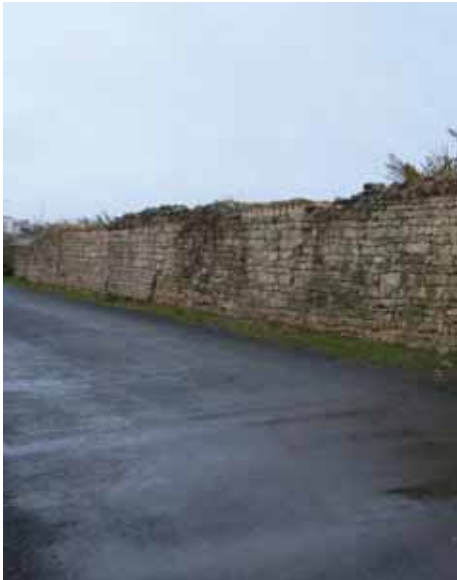
Murs bordant la voie publique
