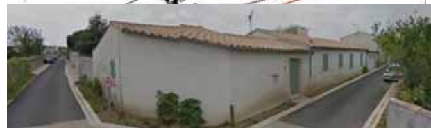
Mur disparu (construction à la place)
