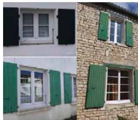
Fenêtres élargies et enduit supprimé
