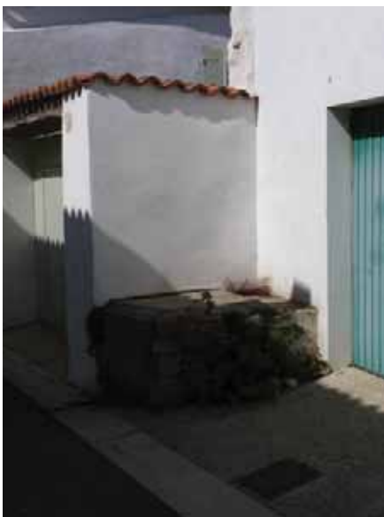
Puits rectangulaires adossés à un mur
