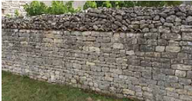
Mur en pierre traditionnel
