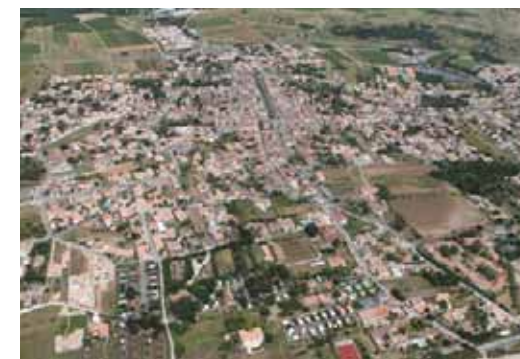
Photo aérienne de La Noue
