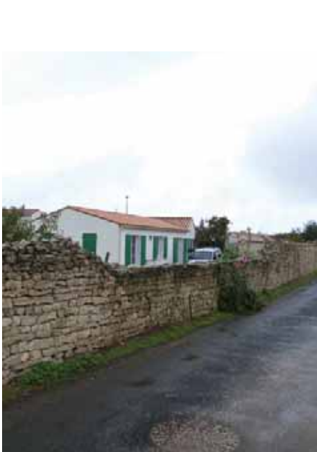
Mur de clos et construction à l'arrière
