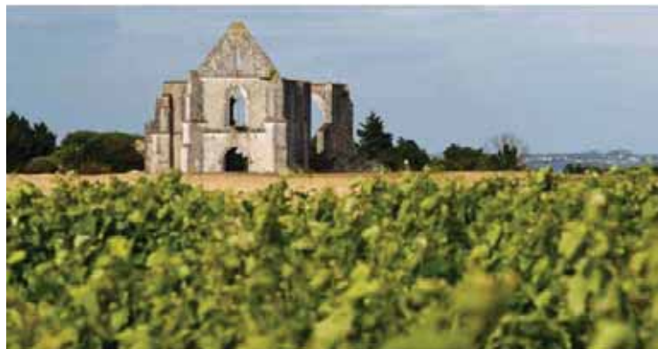
Ruines de l'abbaye des Châteliers (La Flotte-en-Ré)
