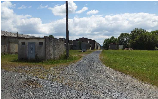
Bâtiments, voiries d'accès et végétation anthropique
