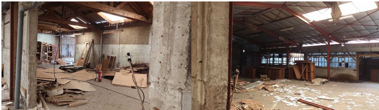
Les espaces où les charpentes sont en bois semblent plus favorables au gîte que les charpentes métalliques doublées d'amiante.
