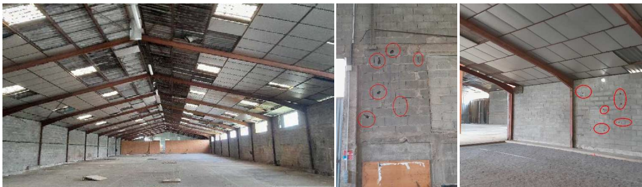
Vue de l'intérieur du hangar sud : de nombreuses loges de parpaings sont utilisées par les Chiroptères.
