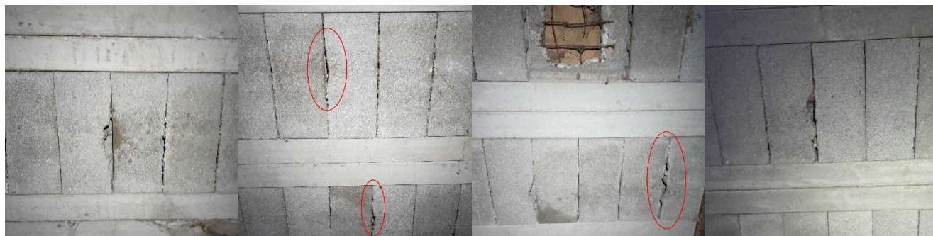
Vue des interstices utilisés comme gîtes dans le tunnel ; les cavités qui sont ou ont été utilisées montrent des marques de passage.
