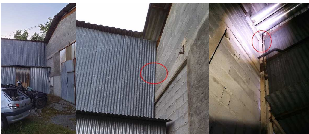
Vue de la localisation du gîte de Pipistrelle commune sur le mur extérieur du hangar sud.
