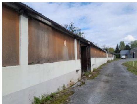
Bâtiments et voie d'accès
