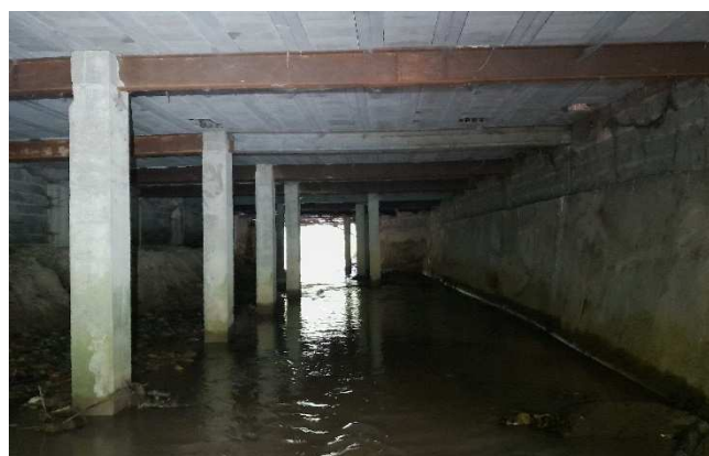
Passage du ruisseau du Laüs sous le bâtiment L
