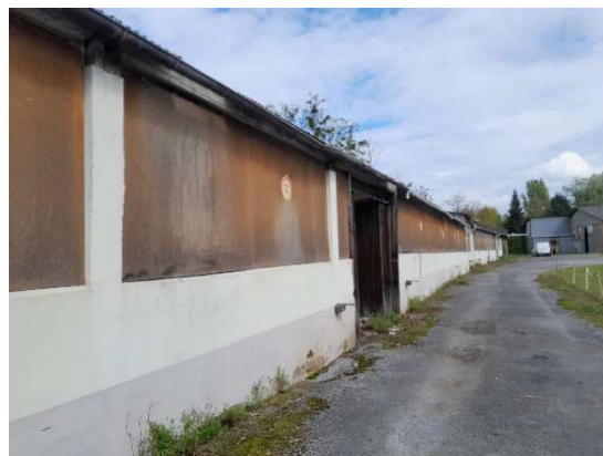
Bâtiments et voie d'accès
