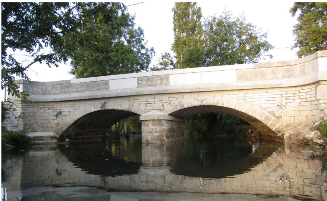
RD 101 Pont de la Jaufrenie - CHAMPAGNE ET FONTAINE
