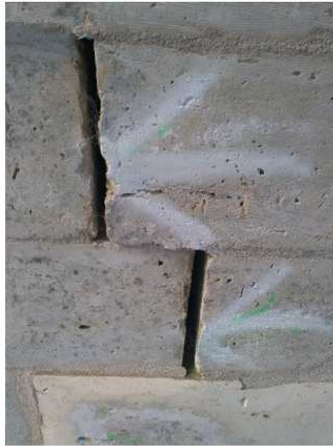
Figure 3: Marquage des disjoints identifiés
