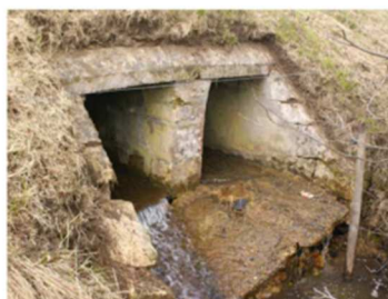
Cheminement d'eau sous le radier et déstabilisation des murs en aile.
