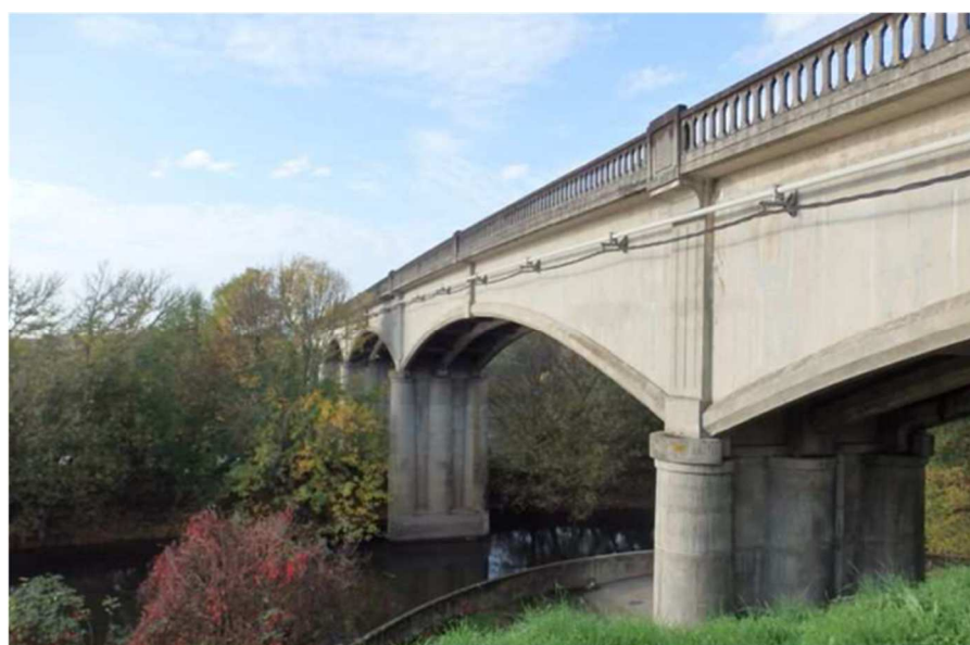
RD 32E Pont du Fleix
