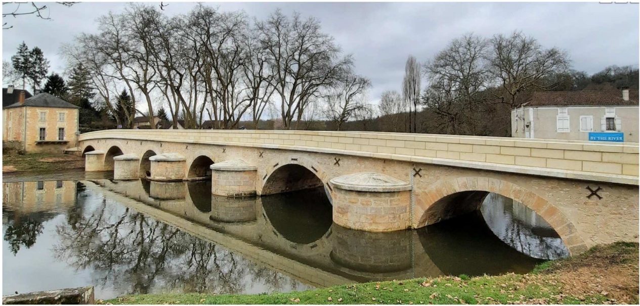
RD 68 - Pont de CUBJAC
