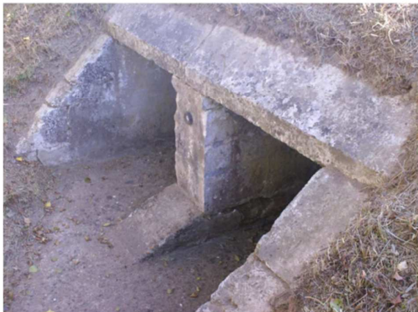
Cheminement d'eau sous le radier et déstabilisation des murs en aile.
