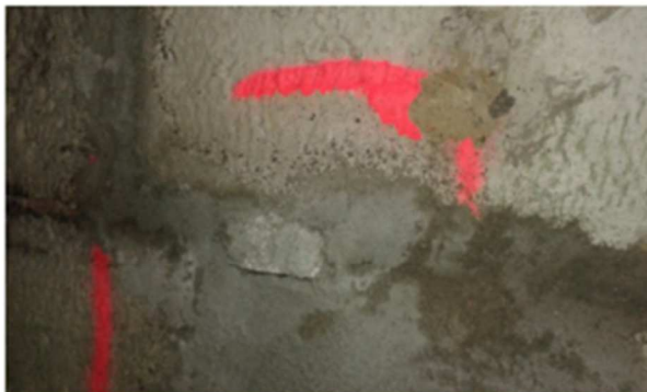
Figure 2: Marquage et maintien d'un interstice favorable aux chauves-souris pendant les travaux
