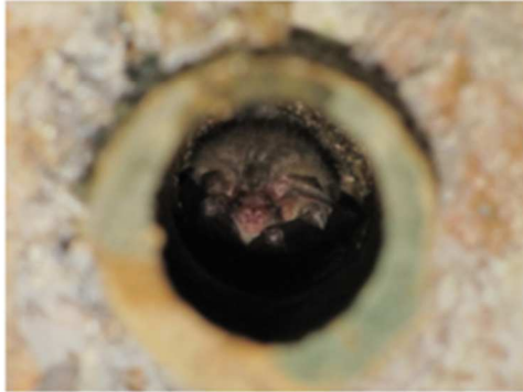
Figure 1: Oreillard au fond d'un drain
