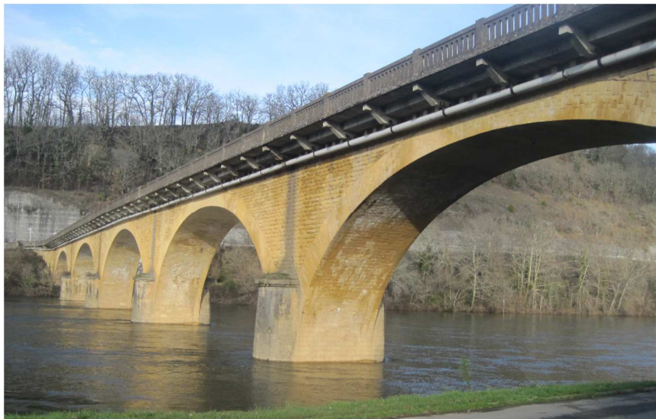
RD 51E - Pont de Vic – LE BUISSON-DE-CADOUIN / SAINT CHAMASSY
