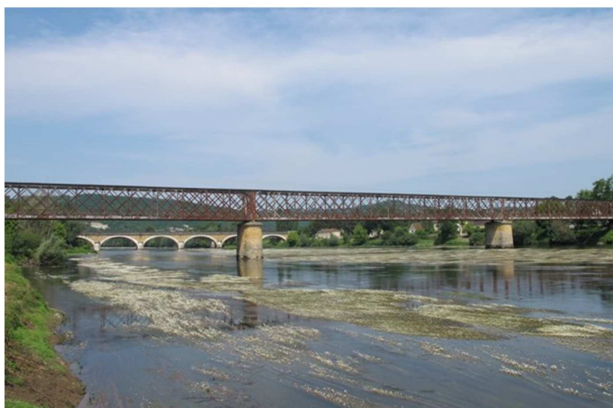
RD 48 – Pont du Garrit – SAINT CYPRIEN / BERBIGUIERES
