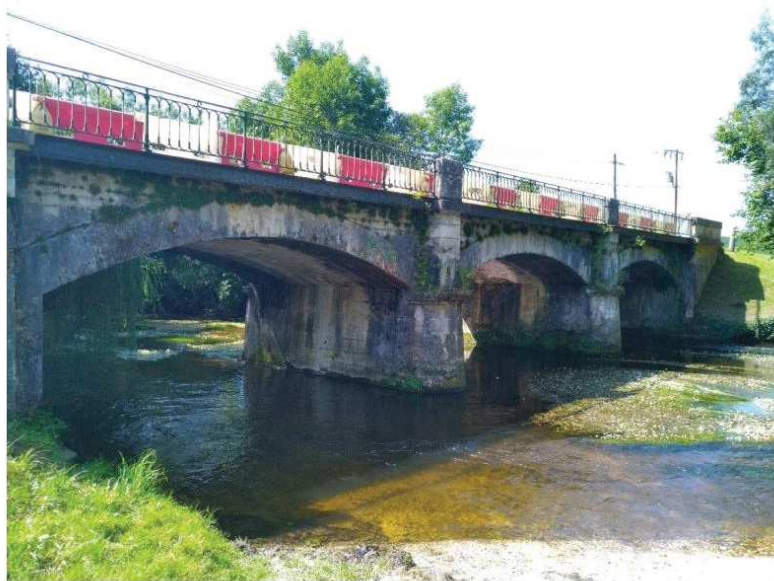
Figure 1: Vue générale de l'ouvrage
