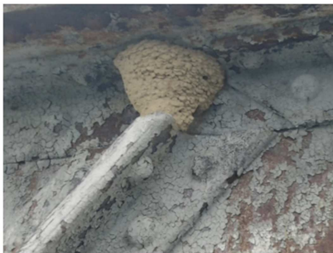
RD 704 Pont du Garrit (ouvrage métallique – présence sur le haut de la structure) - Photo CD 24
