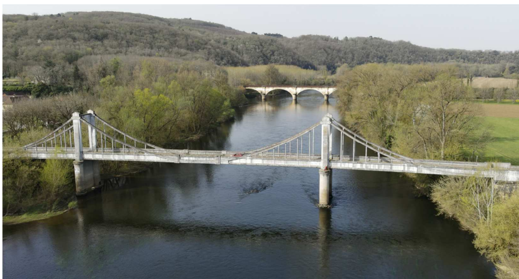
RD 704 – Pont de GROLEJAC
