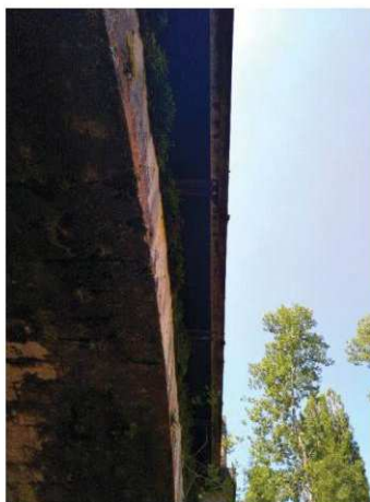
Figure 3: Espacement entre poutres métalliques favorable
