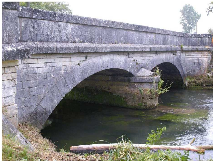
Figure 1 : Vue générale de l'ouvrage
