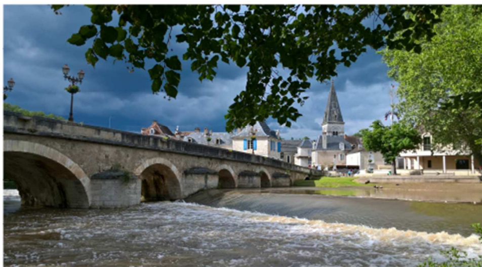
Vue générale amont.
