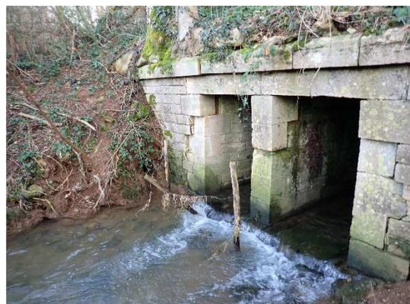
Figure 2. Buses permettant l'écoulement du ruisseau.
