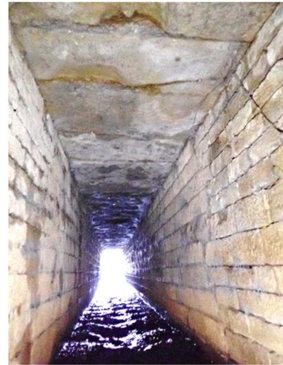
Figure 3. Vue de l'intérieur d'une des deux buses de l'ouvrage d'art.
