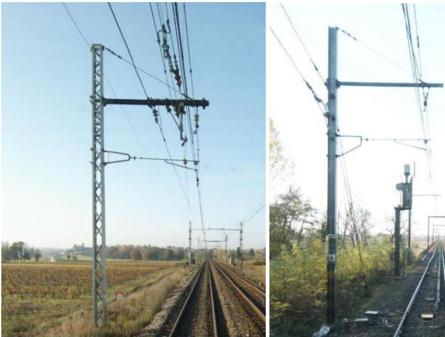
*Photo 30 : Différents types de supports caténaïres en amont du viaduc - poteau en « t » (source SNCF)*
