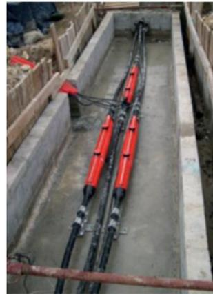
Figure 19 : Exemple de chambre de jonction
