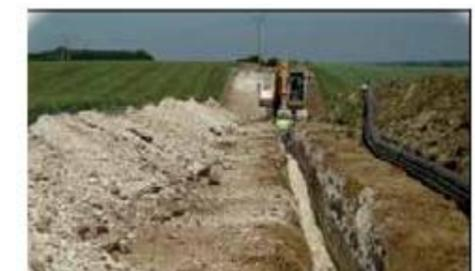
Figure 17 : Réalisation de la tranchée puis déroulage des fourreaux PEHD le long de la fouille avant de les descendre
