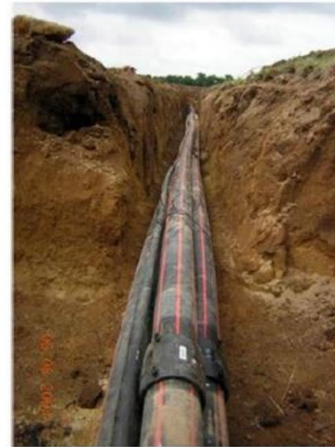
Pose type d'une liaison souterraine en fourreaux PEHD
