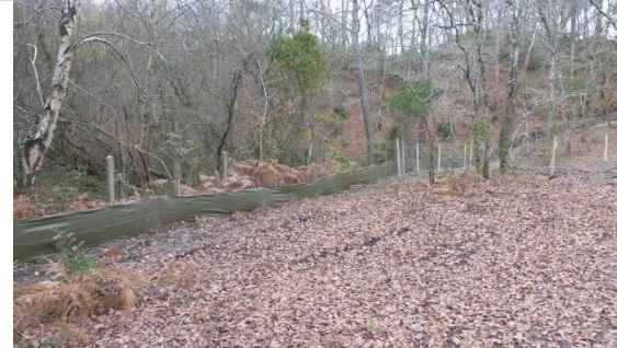
Exemples de barrières anti-batraciens ceinturant un chantier de construction (Source : Simethis)
