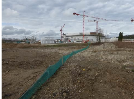
Exemples de barrières anti-batraciens ceinturant un chantier de construction (Source : Simethis)
