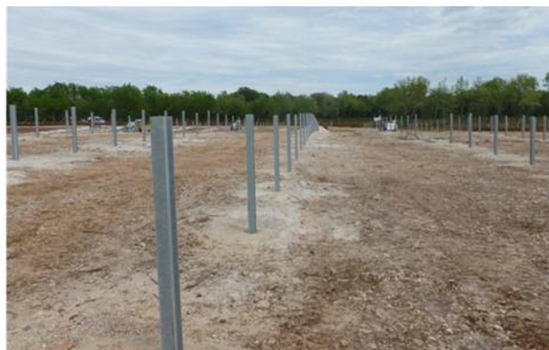
Fig. 8. Ancrages de type pieux battus
