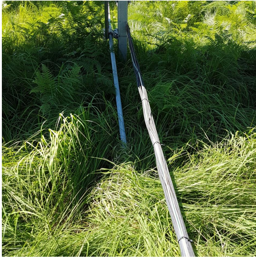
Photo 6 : Exemple d'une barre tordu par la végétation en développement
