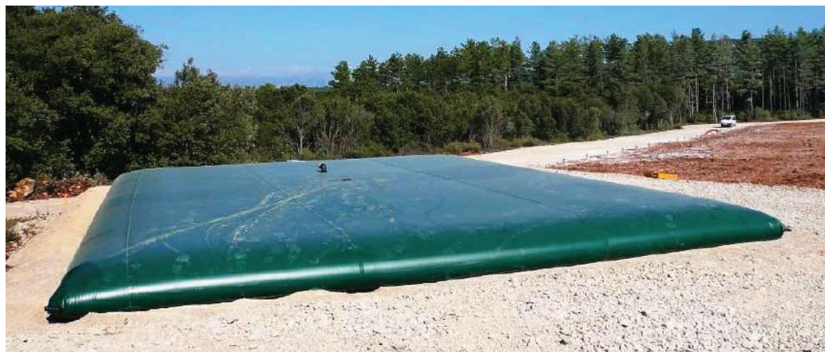
Fig. 12. Exemple de citerne incendie
