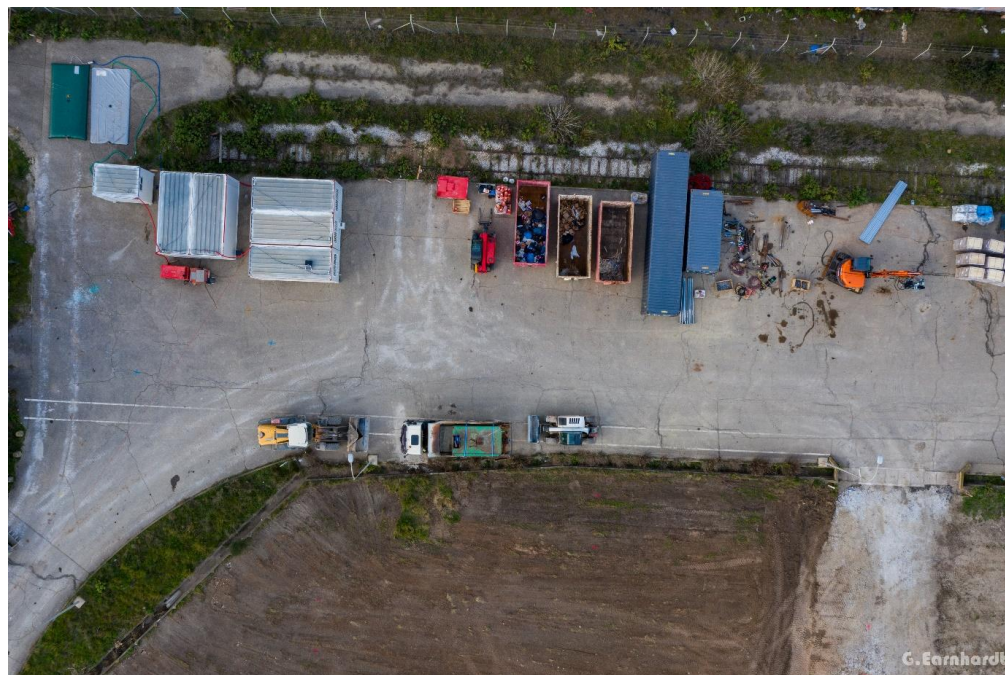
Fig. 15. Photo d'une base vie – source Urbasolar
