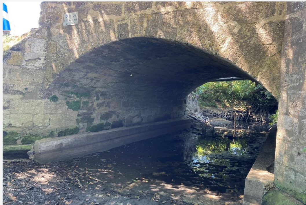
Figure 58 : Ouvrage existant : banquettes accessibles uniquement en période de très basses eaux
