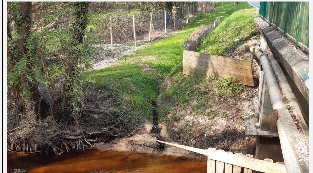
Figure 60 : Exemple de palissades en bois (Source : Conseil Départemental de la Gironde)
