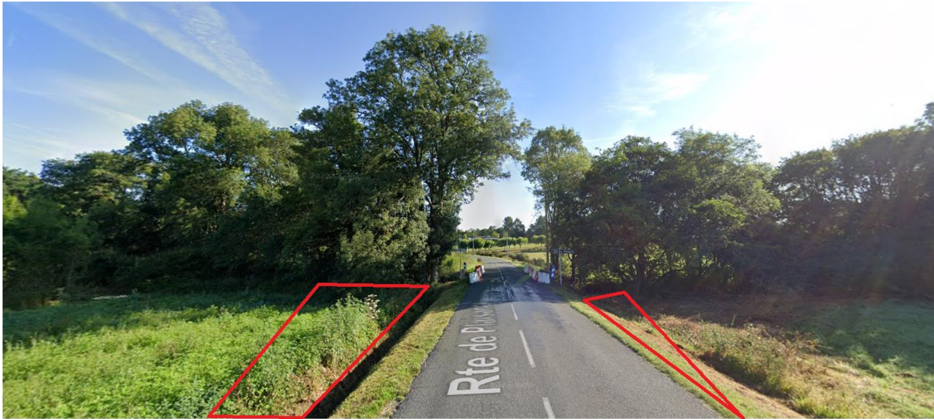
Figure 55 : Zone de remaniement des talus (sud)
