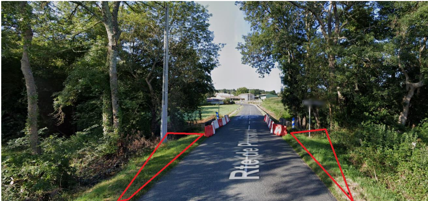
Figure 56 : Zone de remaniement des talus (nord)
