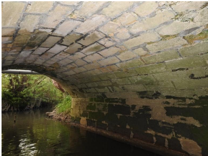
Figure 37 : Photographie de la structure du pont
