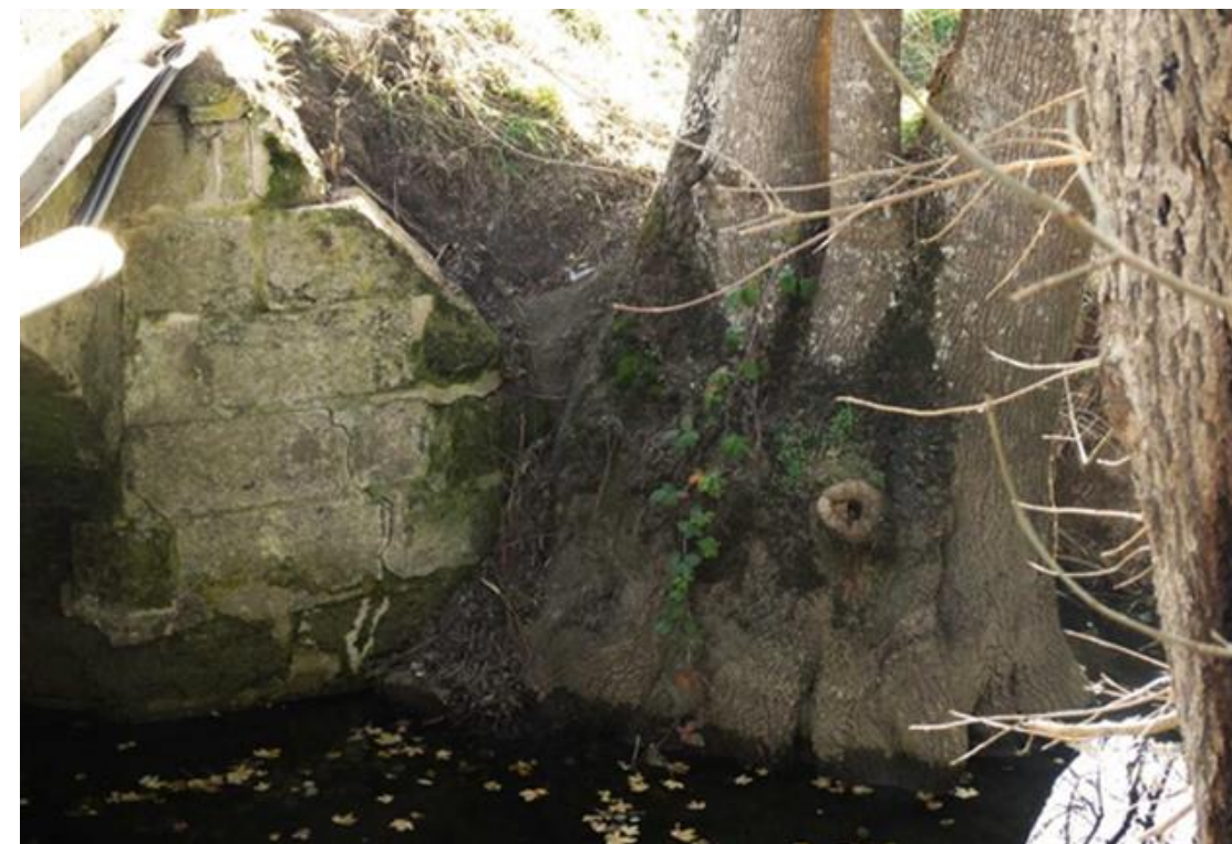
Figure 8 : Pousse d'un arbre au niveau d'une aile prolongeant le pont
