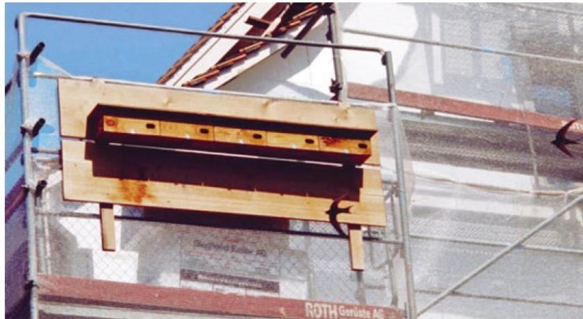
*Figure 15 : Exemple d'installation temporaire de nichoirs à Martinet noir sur un échafaudage (Source Scholl 2016)*
