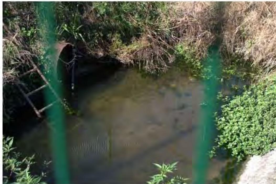
P5 : Cours d'eau au niveau du bassin de rétention (la buse visible est le départ de la partie busée)
