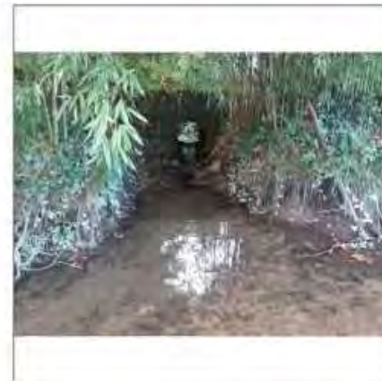
Vue de l'aval de la station
