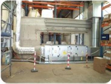
✦ Mise en place d'une capotage étanche sur la cuvette de rétention de la cuve de S2CL2.
