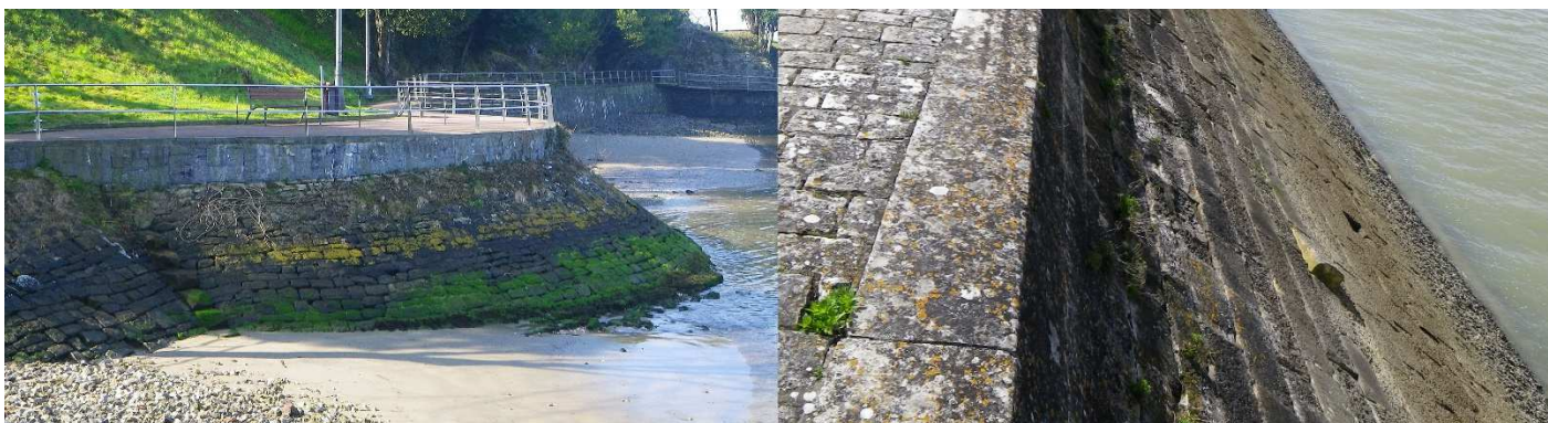
Illustration (protection de berge et quai portuaire hors secteurs étudiés) de désorganisation et mise en mouvement de moellons constitutifs d'un ouvrage exposé à la marée
