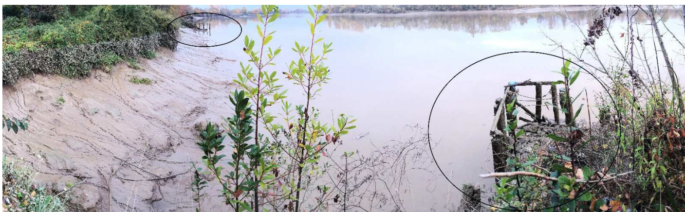
Exemple d'épis implantés dans le lit de la Dordogne (vue panoramique, les épis entourés sont parallèles entre eux). Le dispositif, non maintenu, est aujourd'hui à l'état de ruine
