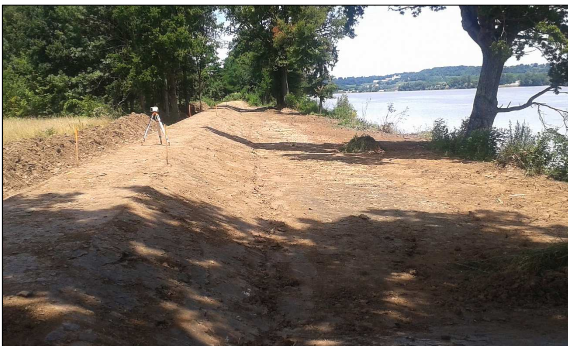
Digue restaurée en retrait par rapport à des berges en régression
