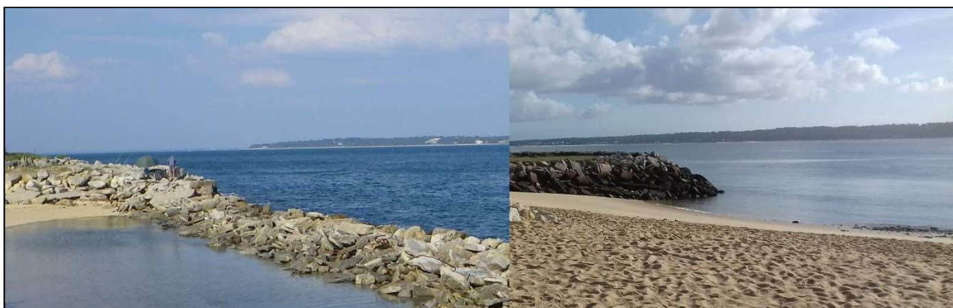
Glissement sub-aquatique régressif ayant emporté un ouvrage en enrochement (à gauche, état en 2011 et à droite, état en 2019)
