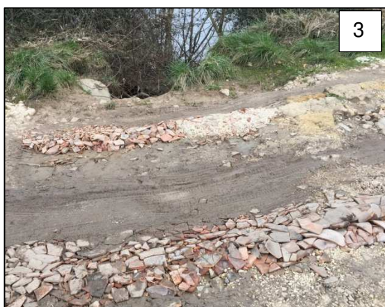
Recul ponctuel de berge contenu par apport régulier de matériaux (2014, 2015, 2016)
