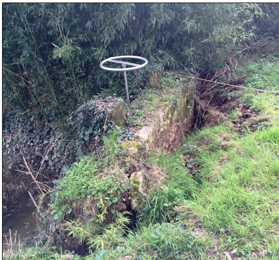
Muret et vanne stables mais désolidarisés du corps de digue
