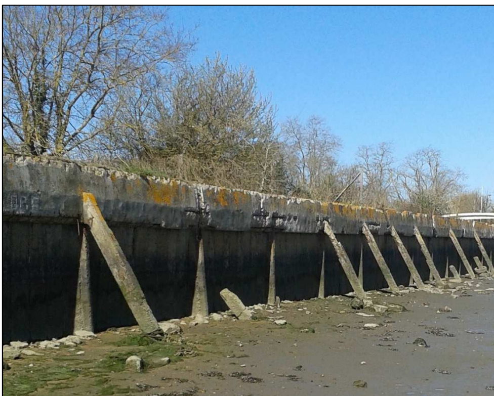
Disparition progressive d'éléments de stabilisation d'un mur de protection côtière
