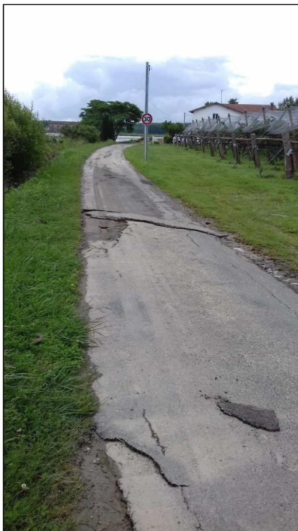
Revêtement de chaussée arraché par un débordement localisé
