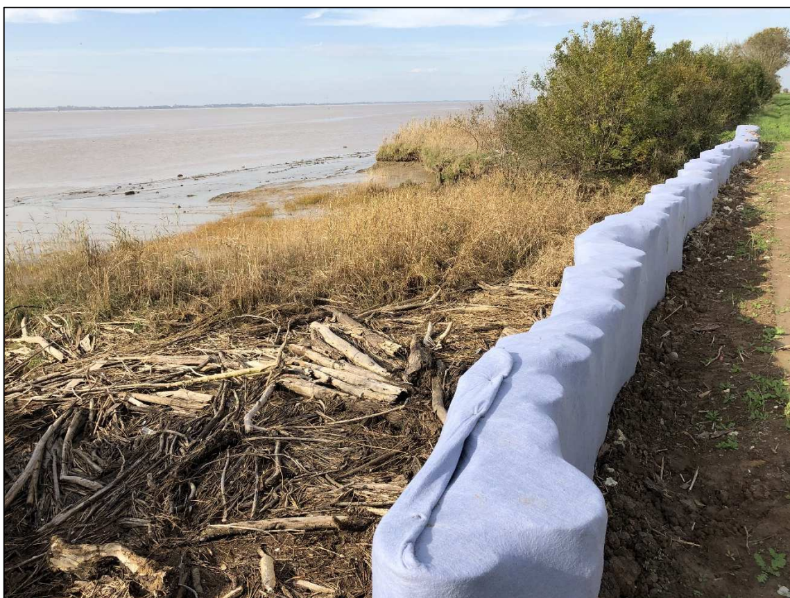
Ouvrage réparé mais situé, en outre dans un environnement particulièrement évolutif (érosion, accumulation de flottants) et à surveiller
