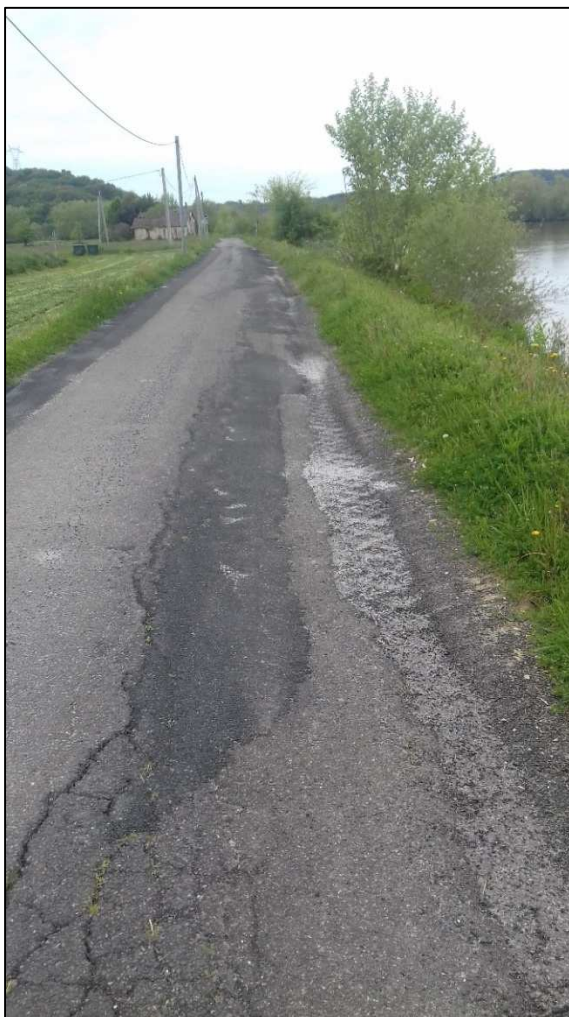
Succession de fissures et réparations touchant une chaussée en remblai sur berge
