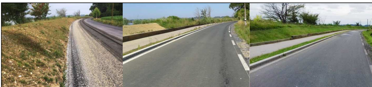
Stades d'une modification pour travaux de voirie et d'une réparation ponctuelle aboutissant, entre 2015 et 2018, à un ouvrage rénové
