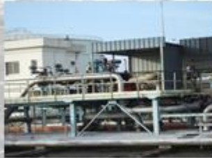
■ Expédition par pipeline
