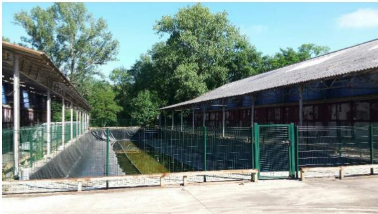
Bassin de récupération des eaux d'incendie de 1000 m 3
